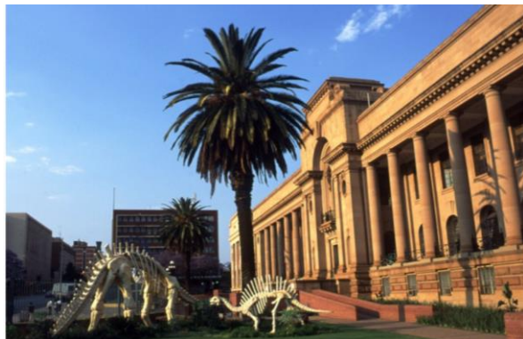
Fasada budynku Transvaal Museum of Natural History, Pretoria (fot. Ł.Przybyłowicz)
